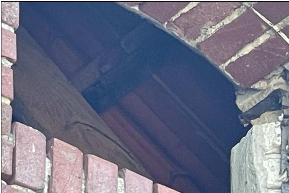
Dakpannen zonder dakbeschot binnen de te slopen bebouwing in het plangebied.
