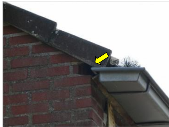
Figuur 4.2 Opening bij dakgoot en kantpannen.
