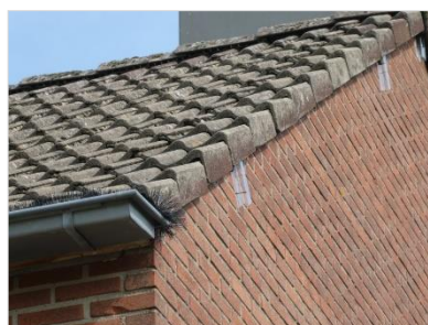
Figuur 2.7 De gevel met dakgoot, kantpannen en exclusion flaps.
