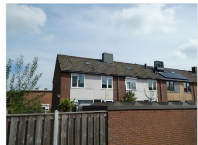
Figuur 2.5 Overzichtsfoto oostzijde appartementencomplex.
