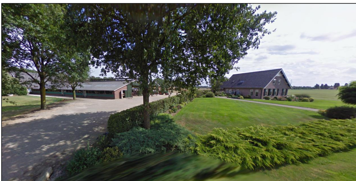
Figuur 5: zicht op planlocatie vanaf Kapelweg (met zicht op woning Kapelweg 13a en bedrijfsbebouwing)
