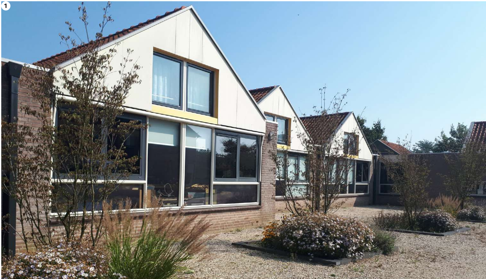
Het huidige schoolgebouw met grote footprint. Geleding van de gevel passend bij het dorps karakter.
