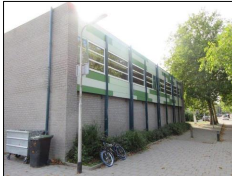
Renovatie Gymlokaal Revelsant (VIV)
