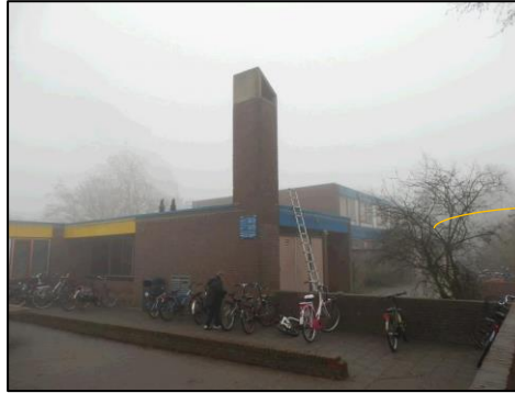
Renovatie Gymlokaal De Zuidert (VIV)
