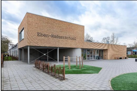
Renovatie Eben Haezerschool (VIV)
