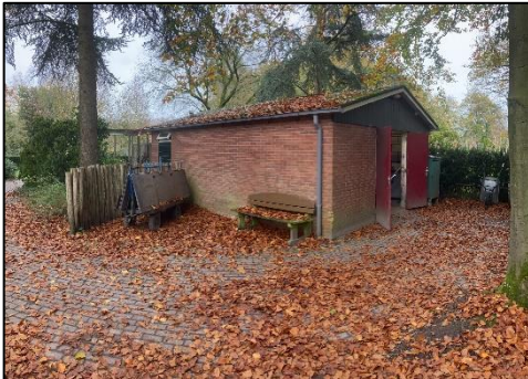
Onderzoek beheerders gebouw begraafplaats (VIV)
