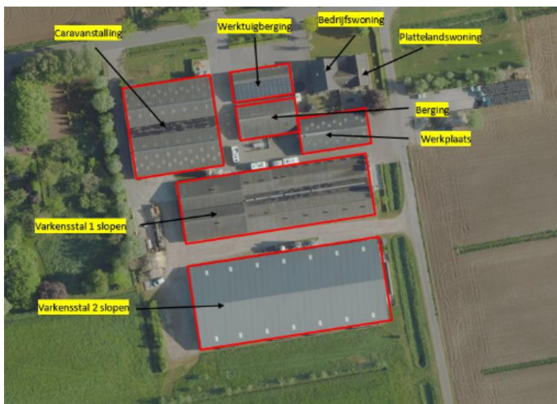
Afbeelding 2.3: Luchtfoto beoogde situatie met kenmerken bebouwing
