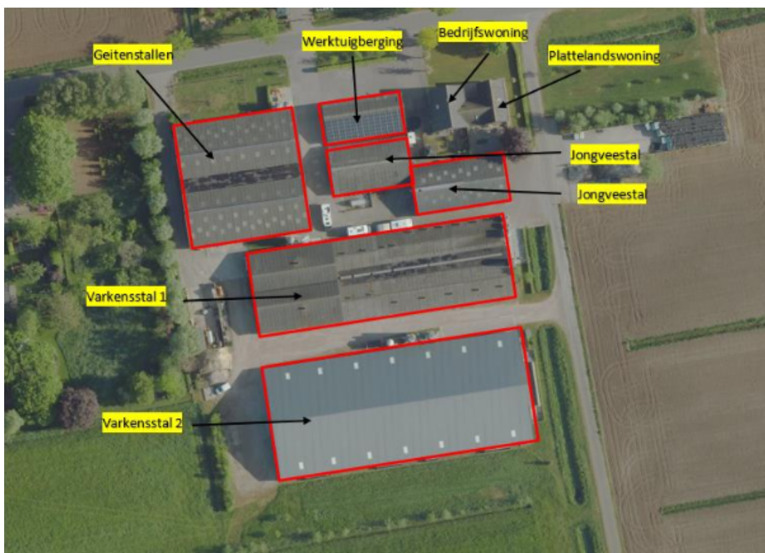
Afbeelding 2.2: Luchtfoto met kenmerken bebouwing
