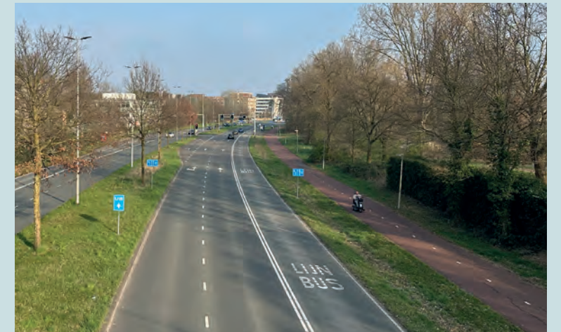
Grote wegen vormen barrières tussen buurten. Omlopen naar een oversteek, maakt loopafstanden te groot. Vaak zijn er ook geen voetpaden langs dergelijke wegen.
