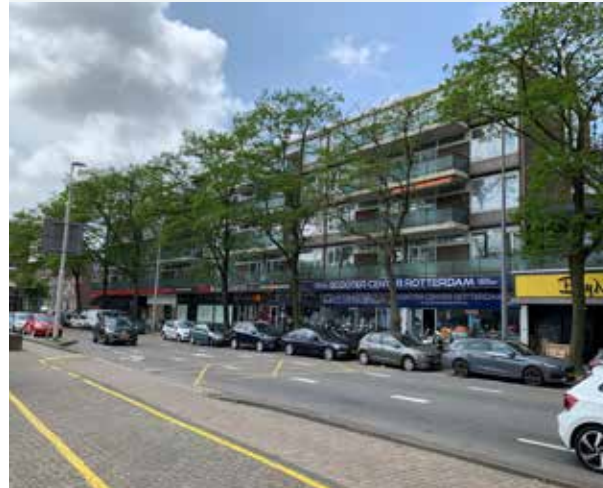
Huidige bebouwing Zuidpleinzijde
