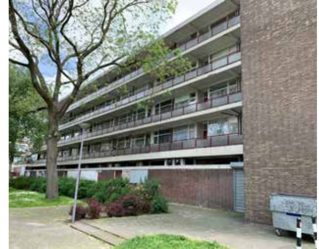
Huidige bebouwing Zuidpleinzijde aan het groene hof
