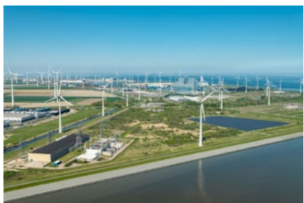
Windturbines in de Eemshaven (foto: RWE)
