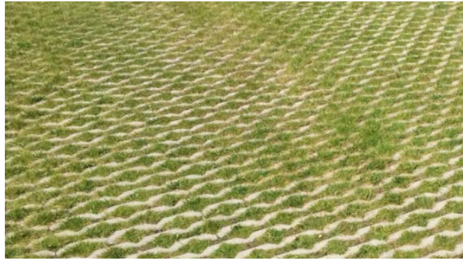
Waterdoorlatende halfverharding voor parkeervakken
