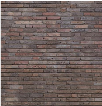
Gedekte tinten in metselwerk
