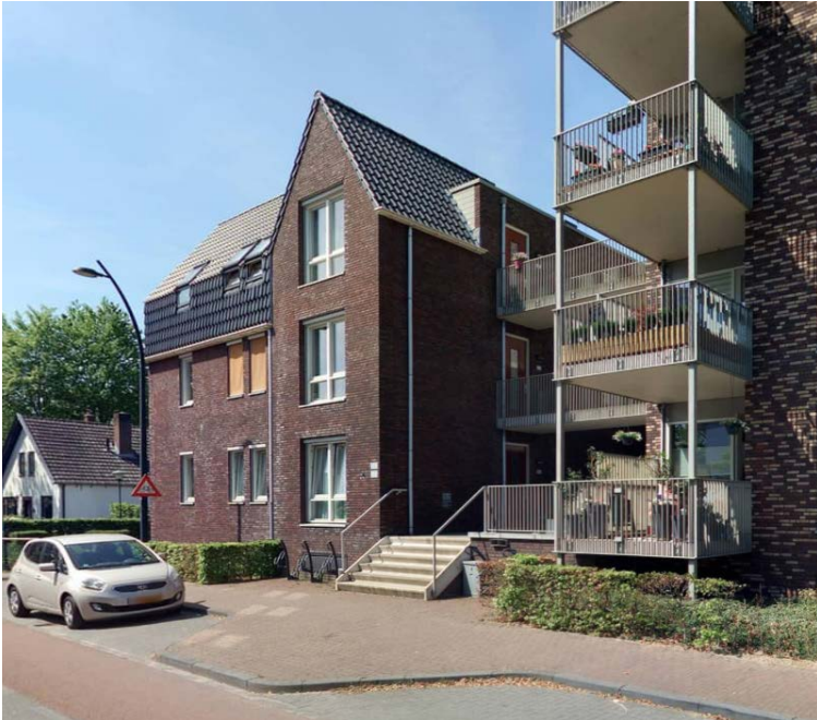
Opbouw met verschillende herkenbare volumes
