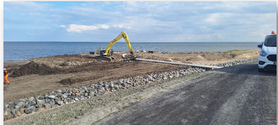
Figuur 3: Werkzaamheden aan de Markermeerdijken
