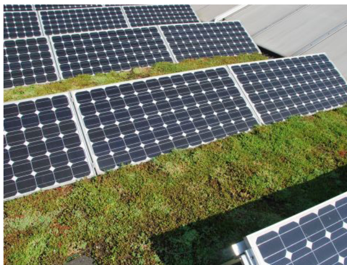
Platte daken als combinatie van vegetatiedak met zonnepanelen.
