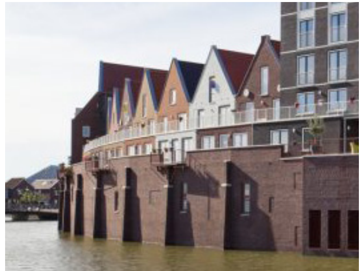
Referentieproject, woningen op kade met penanten en blindnissen
