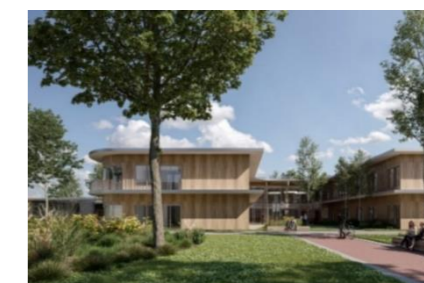
Nieuwbouw HIC gebouw (Landgoed Willibrordus)
