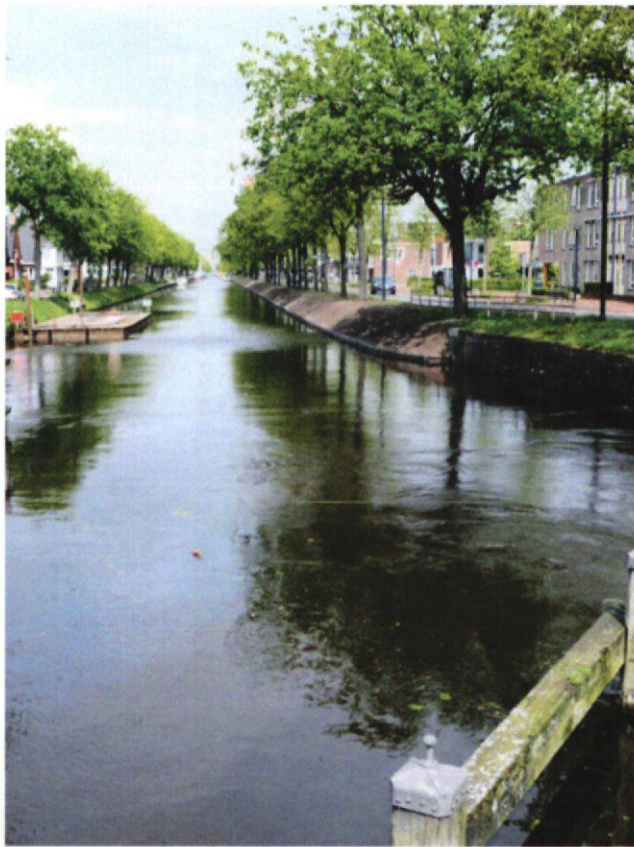
Afbeelding 7 Gemaal in Stads kanaal
