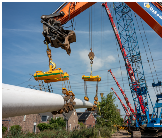
In 2024 legde HVC een nieuwe leiding aan van Sliedrecht, onder de Merwede-rivier door, naar Dordrecht. Via deze leiding wordt 100% duurzame warmte geleverd aan het warmtenet Sliedrecht.
