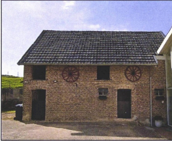
Foto bestaand bijgebouw Winthagen 25
