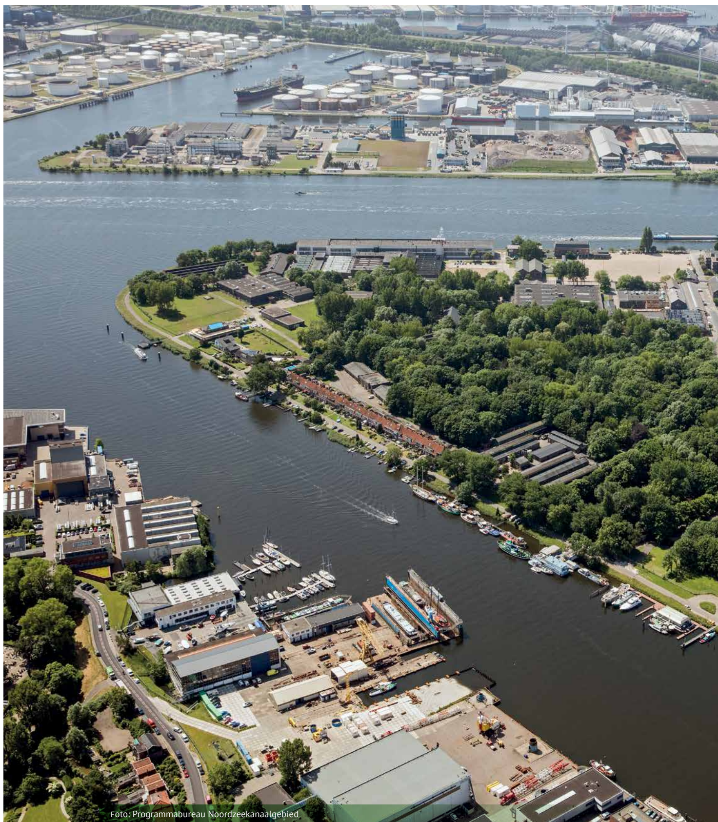
Foto: Programmabureau Noordzeekanaalgebied
