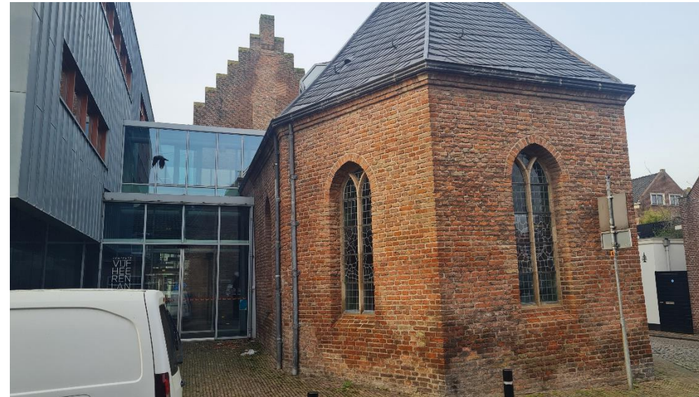
De oostgevel (zijde Kerkstraat), achter de entree gaat de zuidgevel schuil.
