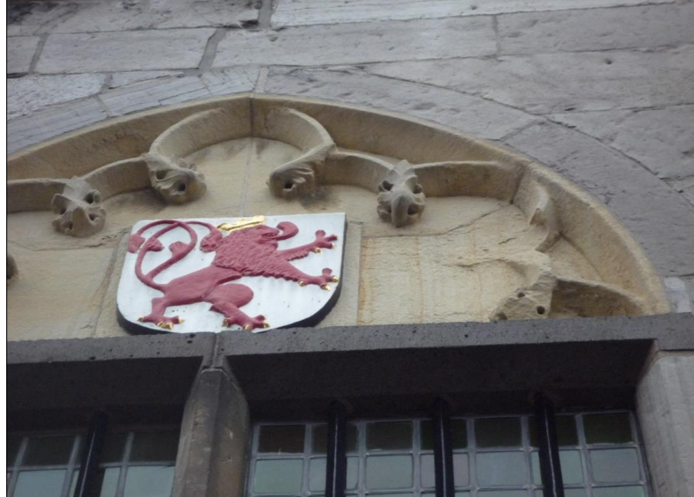
Detail van het maaswerk in een van de spitsbogen op de voorgevel. Het mergel (aangebracht in 1956-1960).
