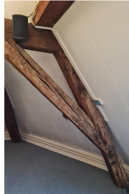
Mogelijk hergebruikt hout voor de spant.
