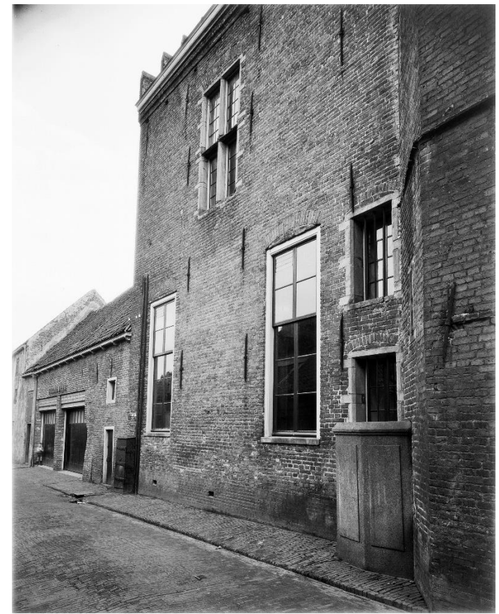
1955 – linkerzijgevel aan de Stadhuisstraat voor restauratie [RCE]
