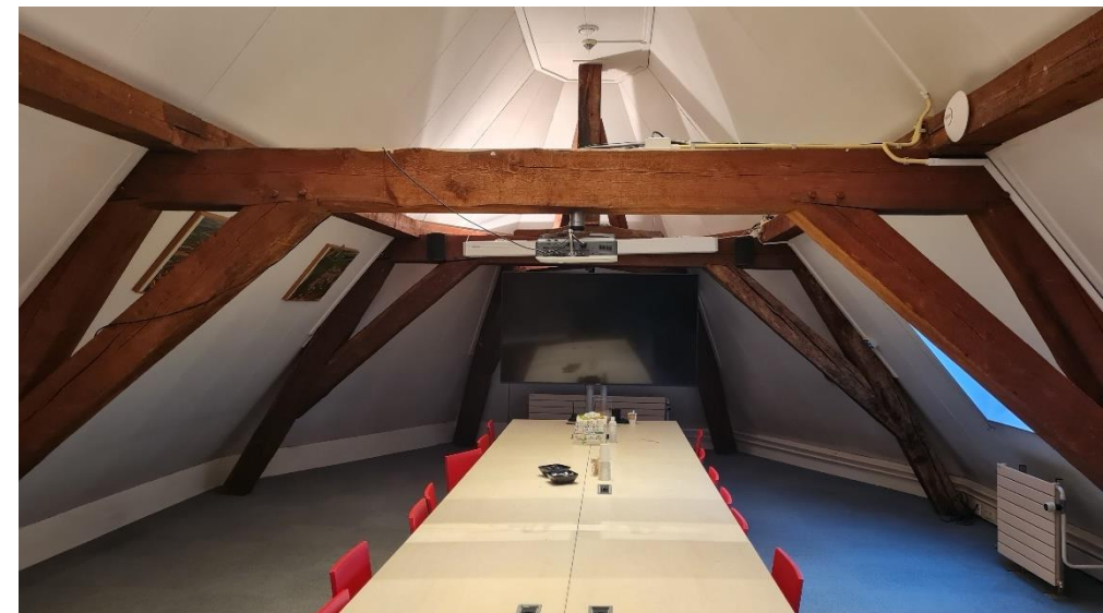
Kapconstructie van de kapel.
