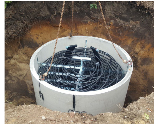
Technische oplossingen: de door de bodemsanering vrijkomende ruimte benutten voor hernieuwbare energie bijvoorbeeld een ijsbuffer
