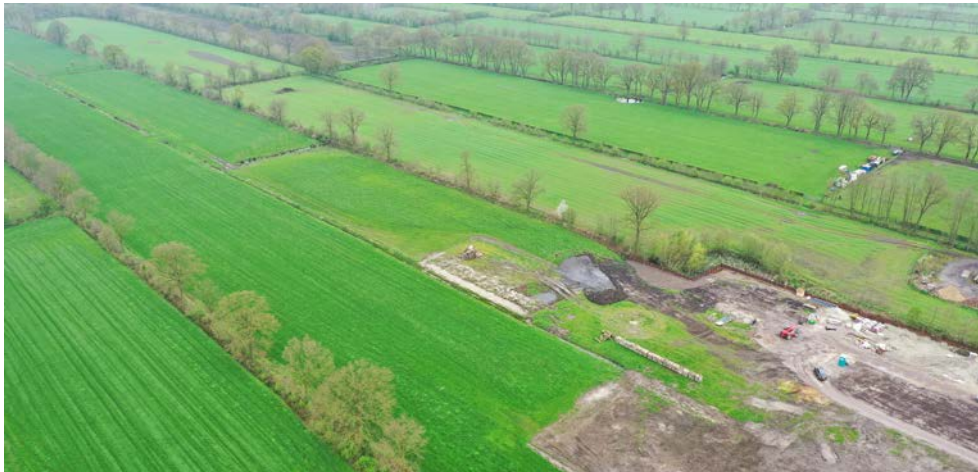
Dronebeeld waarop de waterstructuren zichtbaar zijn
