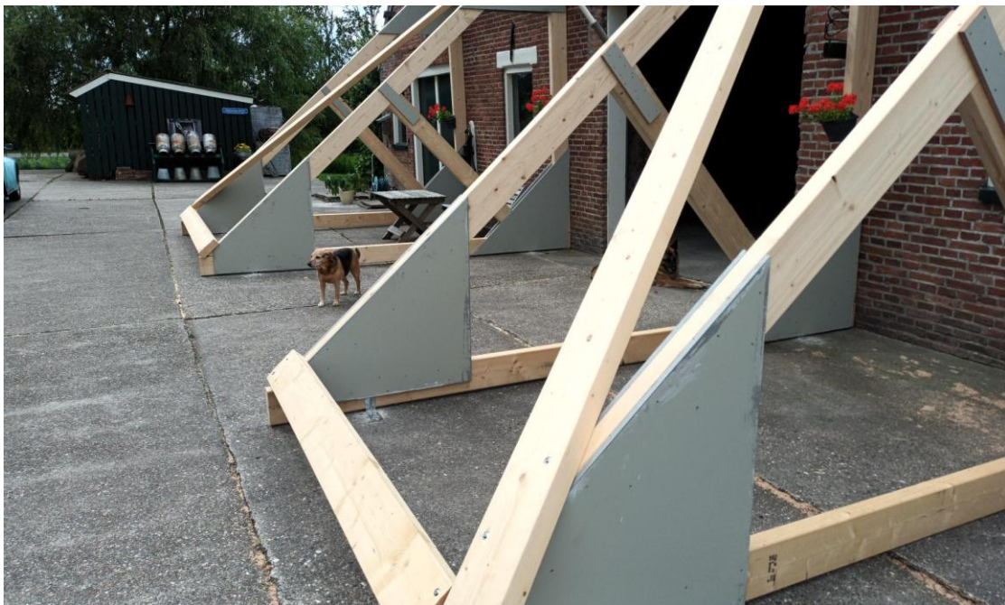
Figuur 1: Voorbeeld stutconstructie
