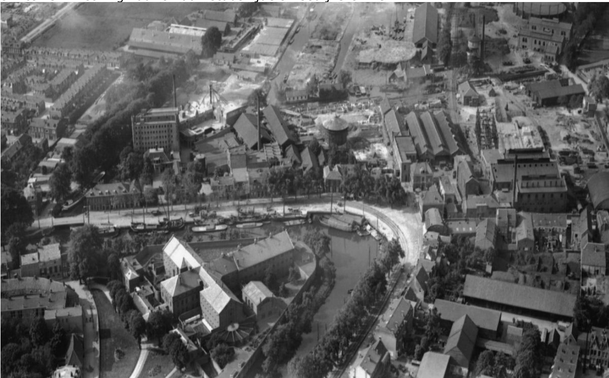
Figuur 3.1: Luchtfoto van de Wittevrouwensingel en de gevangenis aan het Wolvenplein (1923)
