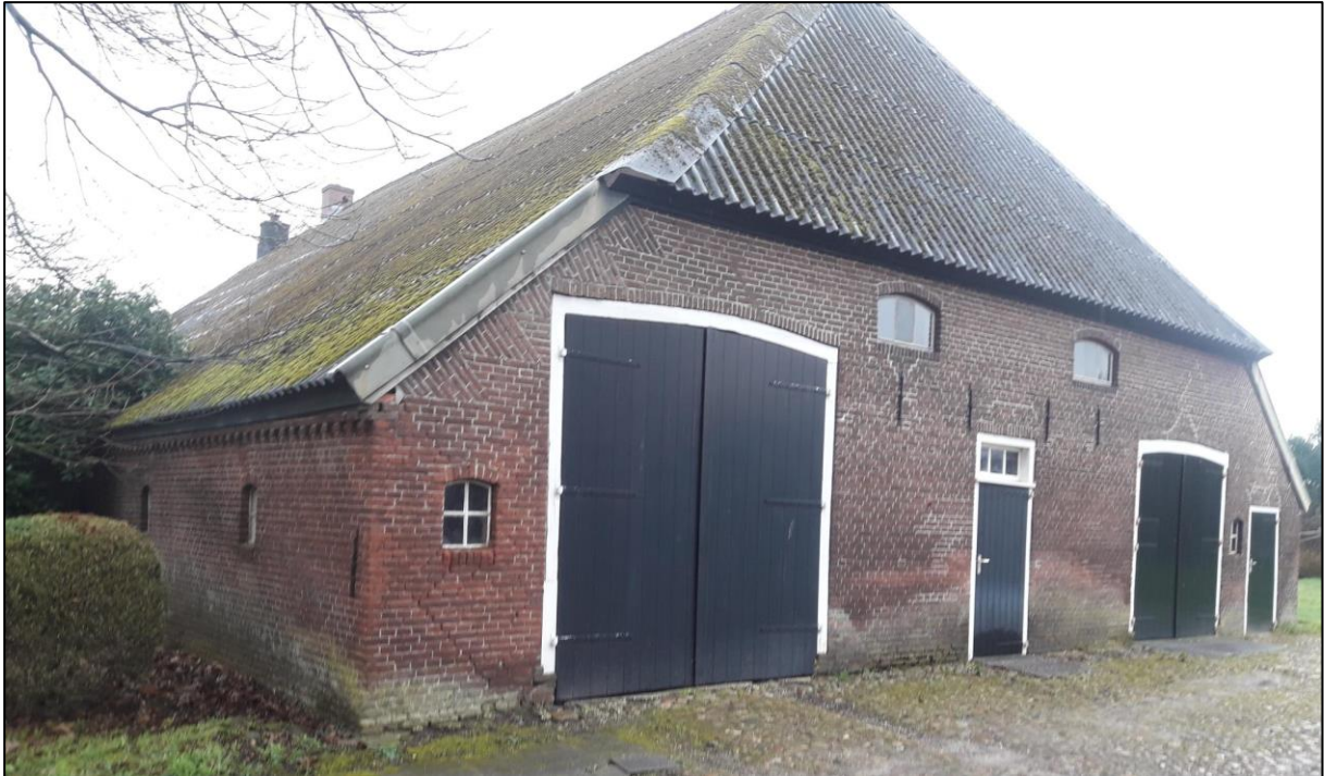
Figuur 2.3 Stal Asserstraat 5.
