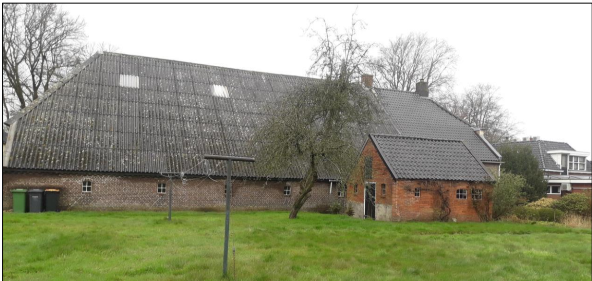
Figuur 2.2 Achterzijde Asserstraat 5 met losstaand schuurtje.
