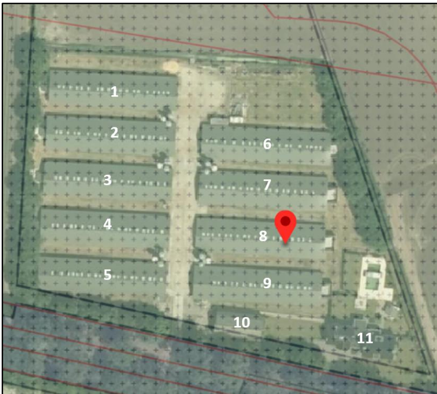
Afbeelding 3 Luchtfoto huidige situatie plangebied
