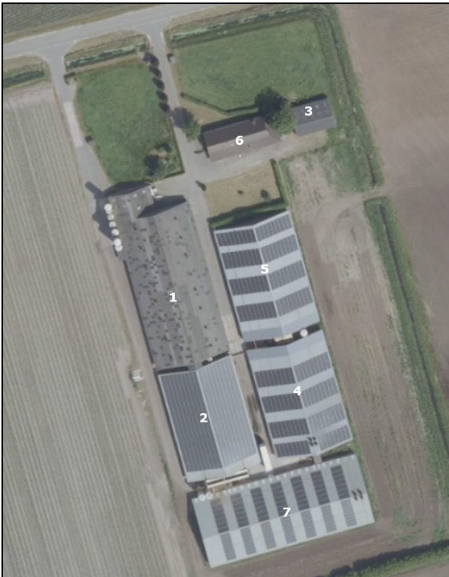
Afbeelding 7 Luchtfoto huidige situatie plangebied
