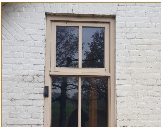
Afbeelding 24: Midden van het plangebied. Kozijn van de woning. Geen geschikte openingen rondom het kozijn.
