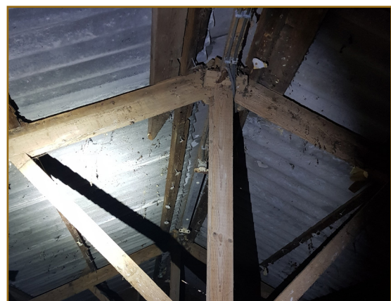
Afbeelding 9: Binnenkant van de kalverenstal. Dakbedekking is volledig te overzien. Geen esten aangetroffen.
