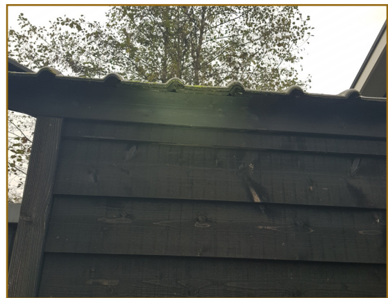
Afbeelding 13: Tijdelijke woonunit. Geen openingen onder dakbedekking aanwezig.
