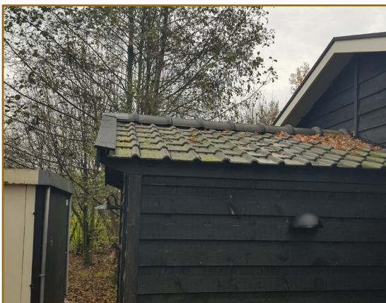
Afbeelding 14: Tijdelijke woonunit. Geen openingen (onder dakbedekking) aanwezig.
