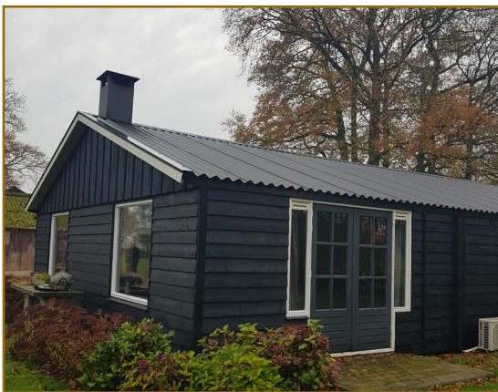
Afbeelding 12: Tijdelijke (nieuwe) woonunit op het oostelijk deel van het perceel.
