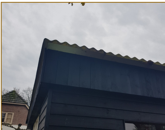
Afbeelding 20: Noord-westzijde van het plangebied. Tijdelijke woonunit. Geen openingen aanwezig.
