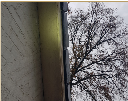
Afbeelding 26: Midden van het plangebied. Woning. Geen geschikte openingen onder de dakrand.
