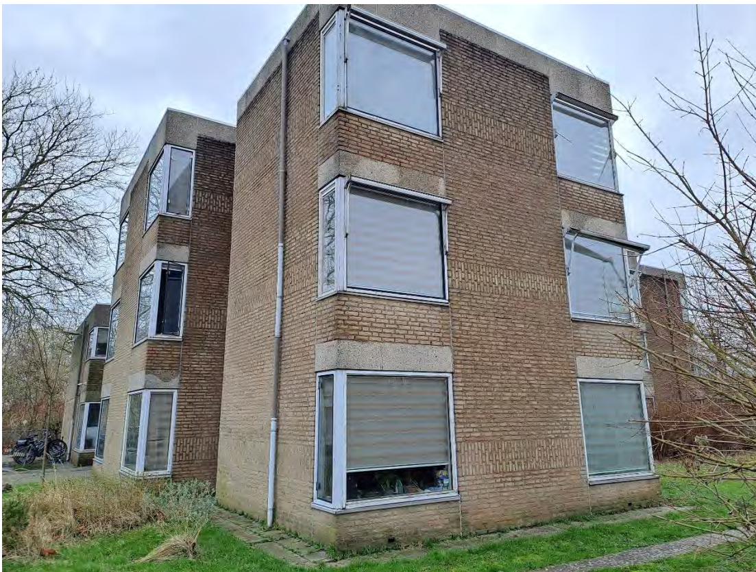
Figuur 2-3 Het complex te midden van het plangebied is drie verdiepingen hoog met een plat dak, de bakstenen muren bevatten open stootvoegen.
