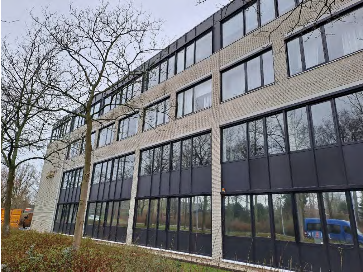
Figuur 5-5 Beide complexen bevatten open stootvoegen onder en boven de ramen, op de foto het meest zuidelijke complex.
