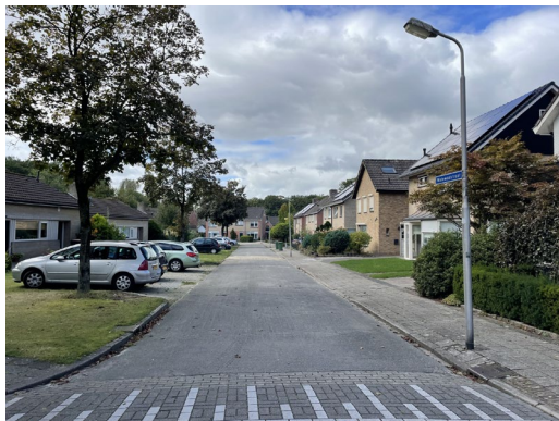
Wielewaalstraat in De Lutte ingericht met asfaltbeton | L. Vlot (2024)
