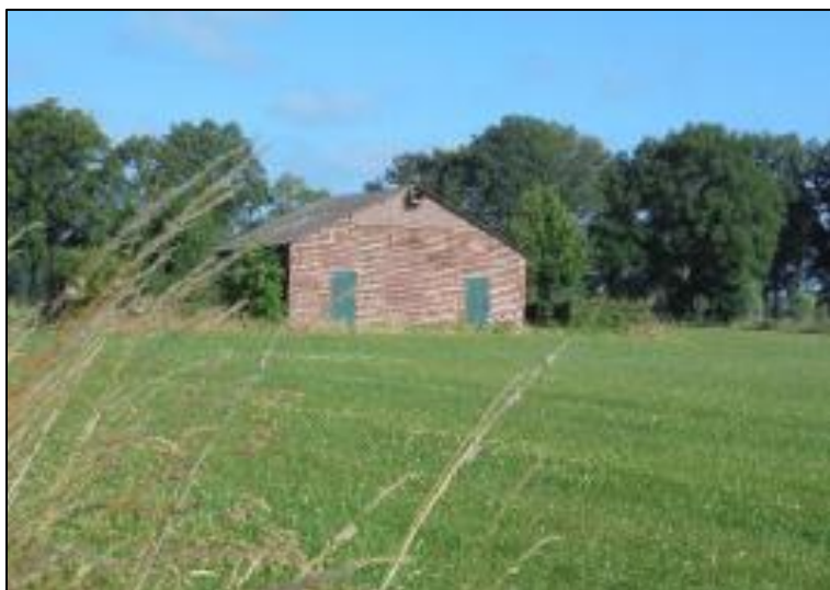
Figuur 11 zicht op planlocatie vanaf de naastgelegen beek gezien
