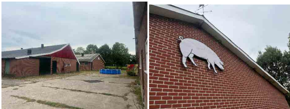
Gebouwen met bakstenen buitengevels en luchtsponw.
