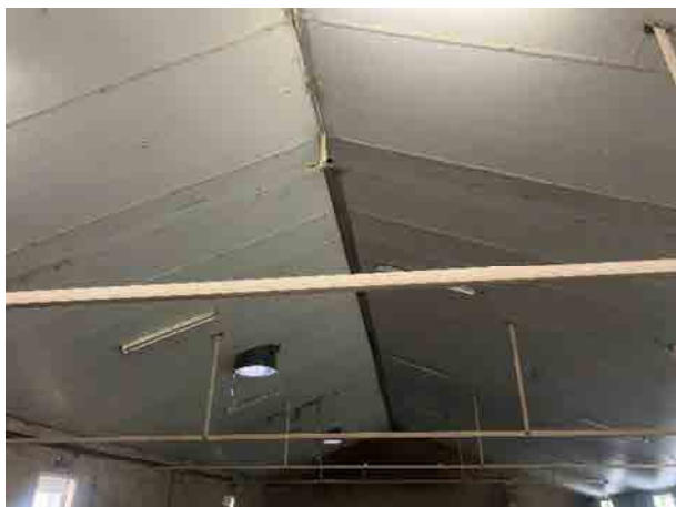
Steenmarters kunnen een verblijfplaats bezetten tussen golfplaten en dakisolatie.
