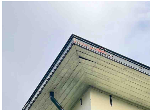
Figuur 13 & 14. Aansluiting van de goot op de gevel (l) en loszittende schroten van de gootbekisting in de zw-hoek (r).
