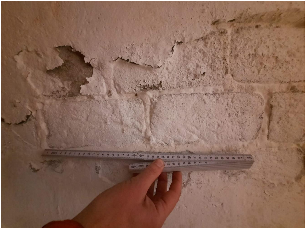
Afbeelding 17. Muur waar de bakstenen zichtbaar waren met duimstok voor schaal.
