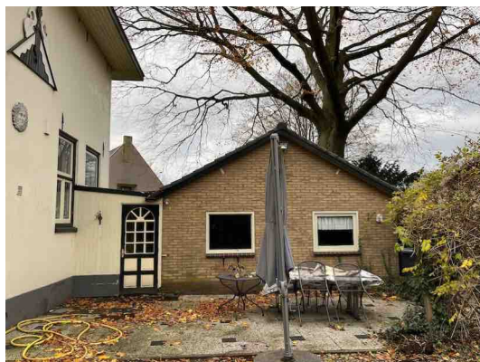
Figuur 6. Geschakeld bijgebouw aan de noordkant.
