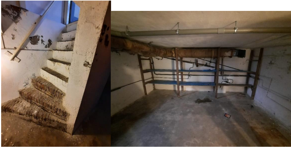
Afbeelding 16. Impressie van de kelder van de bestaande woning.
