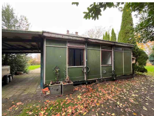
Figuur 8. Losstaand bijgebouw ten zuidoosten van de woning.
