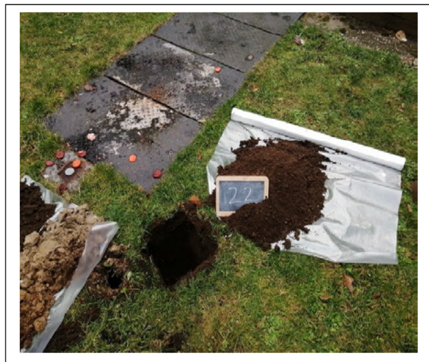
Foto 10. Asbestinspectiegat 22
