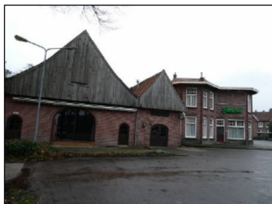
Figuur 2.4 Vooraanzicht van de grote schuur en het hoofdgebouw 'De Harmonie'.
