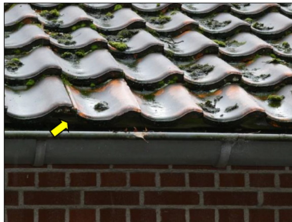
Figuur 5.2 Ruimte onder de eerste rij dakpannen.
