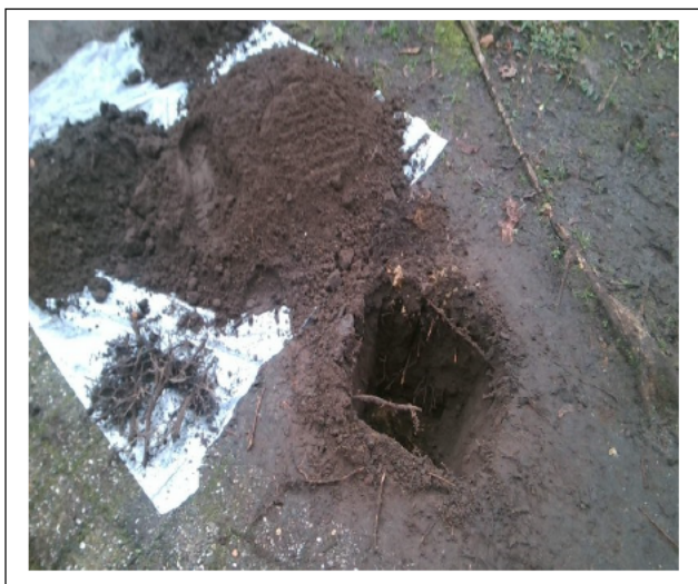
Foto 5. Asbestinspectiegat 05
