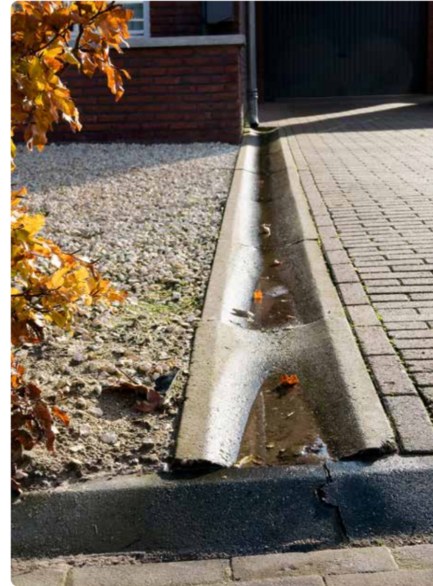
Water wat zichtbaar via een goot op het erf naar de straat loopt
