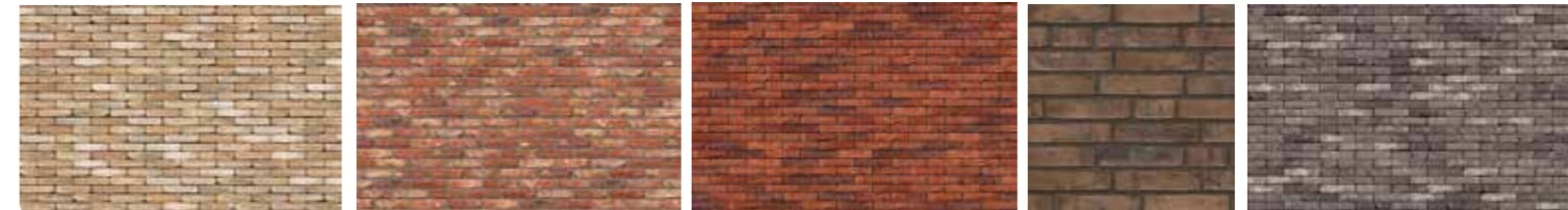
Kleuren metselwerk gevelvlakken
