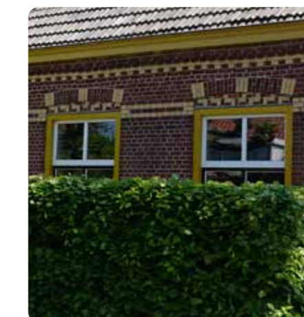
Rijke detaillering raam en gevel
