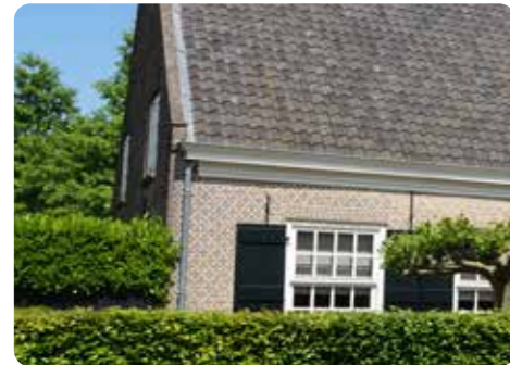
Woonhuis met daklijst en dakkapel
