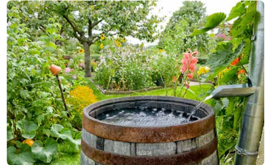
Water van het dak hergebruiken in de tuin door een regenton
