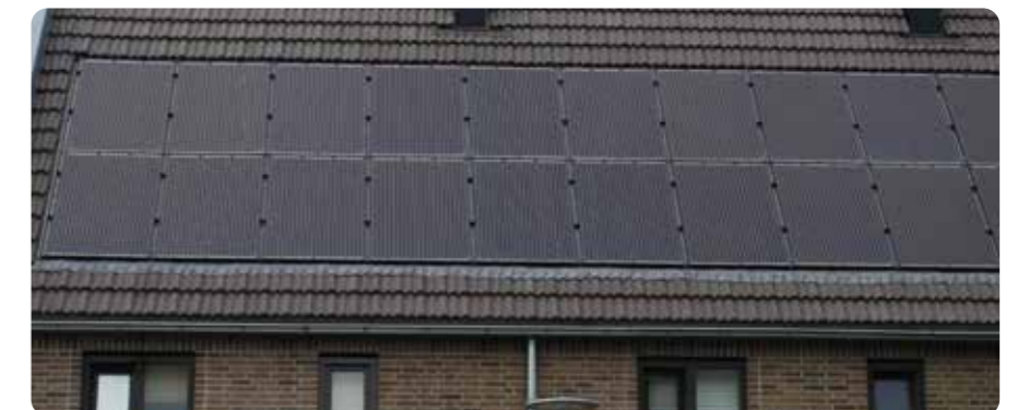
Zonnepanelen verzonken in het dak
