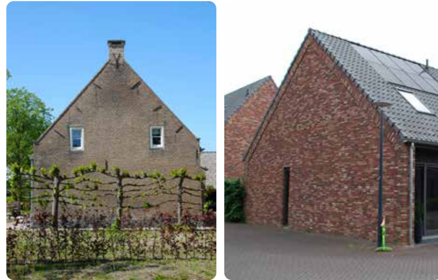
Historische boerderij Etten-Leur ingetogen kopgevel zonder entree en eigentijdse vertaling
