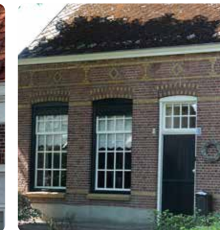
Plint en rijke detaillering raam, deur en gevel
