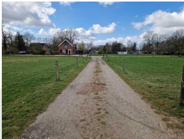
Figuur 12: Oprit met puinverharding
