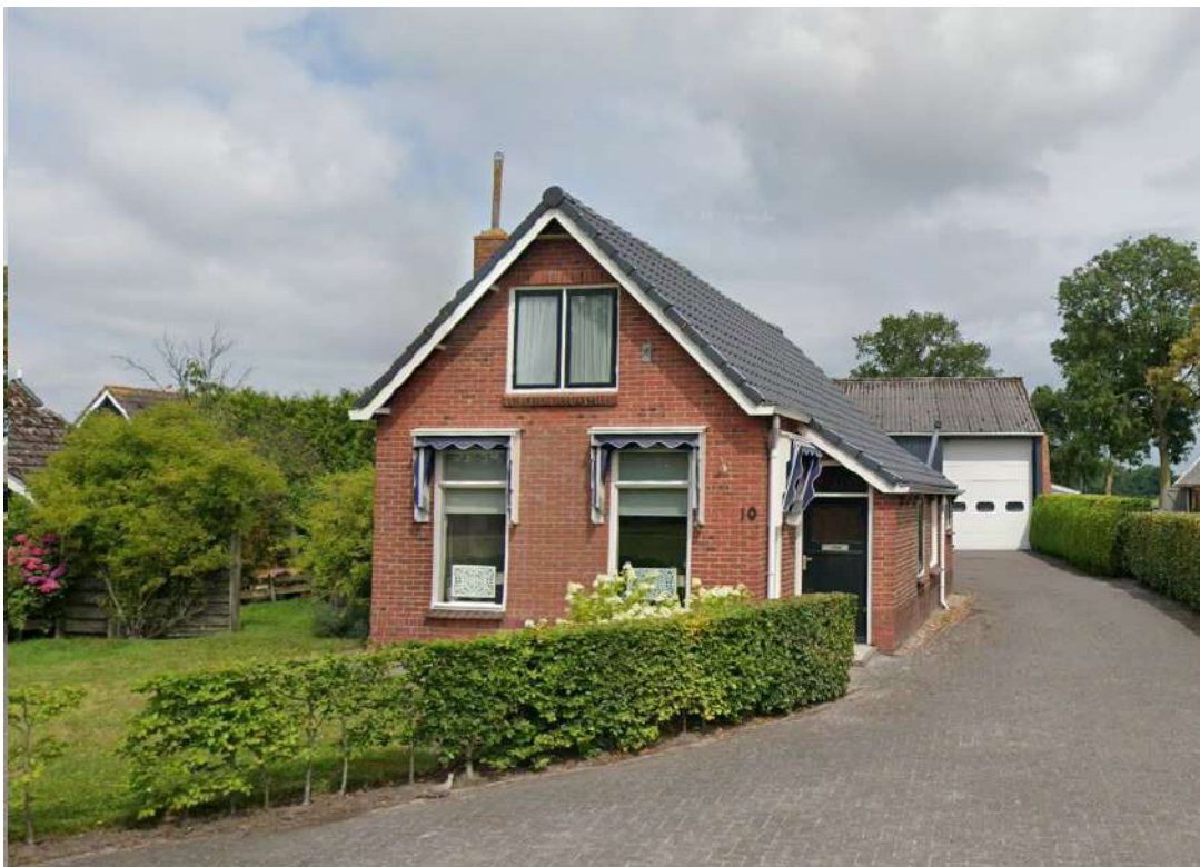
Figuur 2.1 Huidige situatie (bron: Google Street View, 2025)
