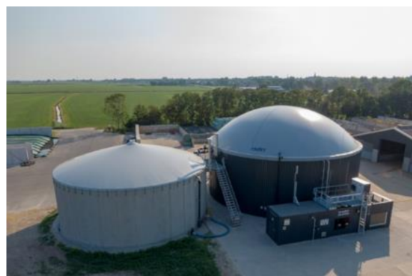
Figuur 3: Na-opslag (links) met vergister (rechts)
