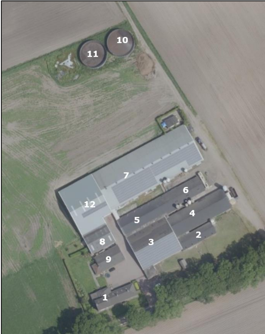
Afbeelding 9 Luchtfoto huidige situatie plangebied
