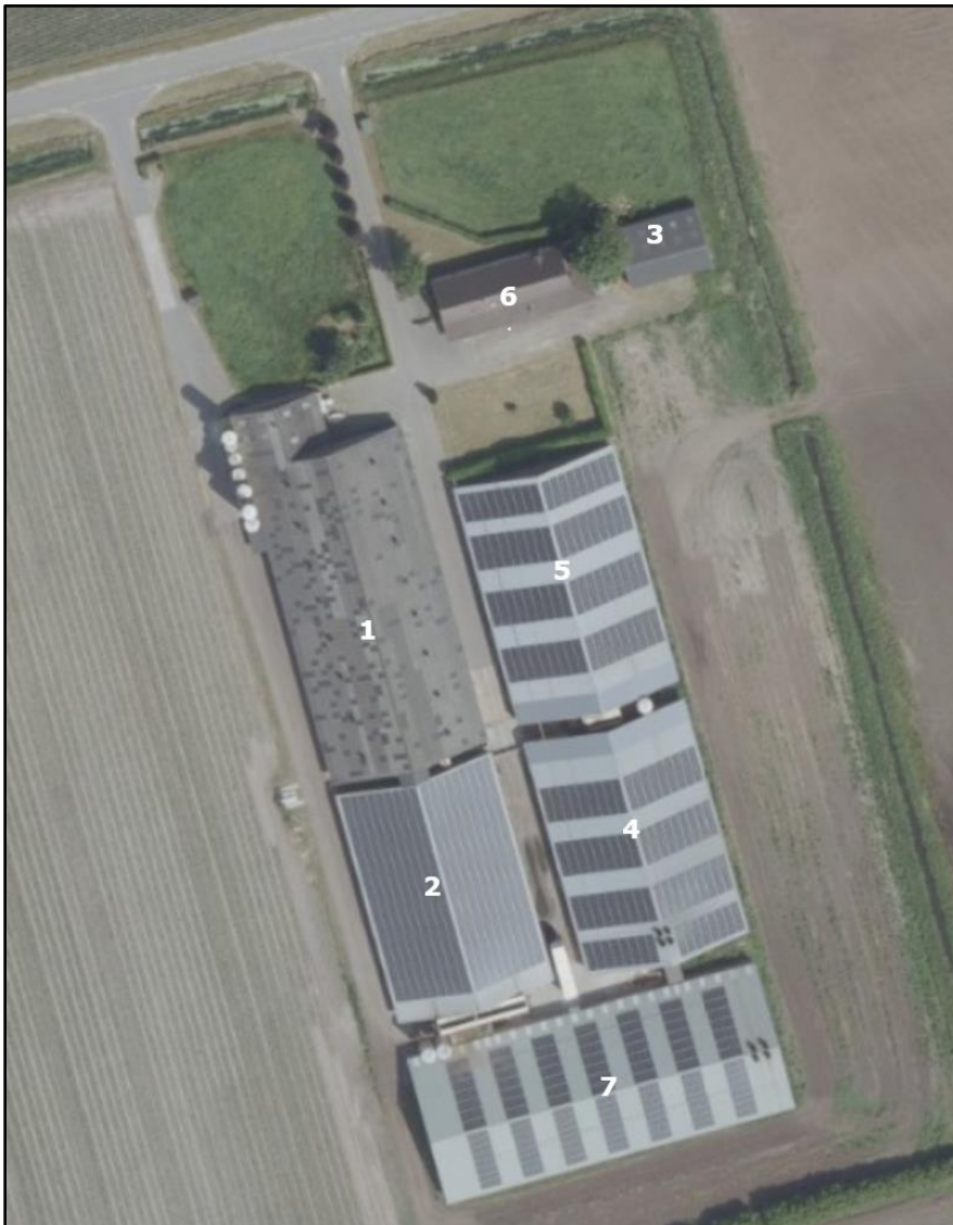
Afbeelding 7 Luchtfoto huidige situatie plangebied
