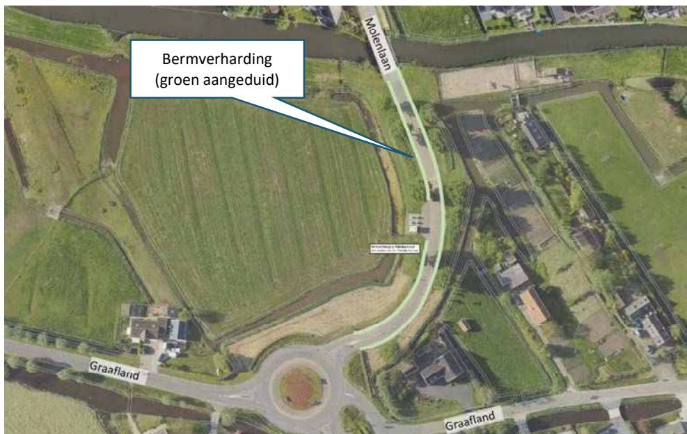
Figuur 3-12 Bermverharding Molenlaan
