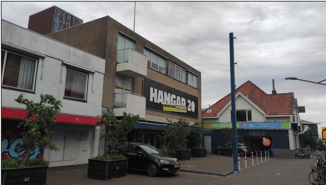
Afbeelding - Huidige bebouwing Hangar 20 en de fietsenzaak
