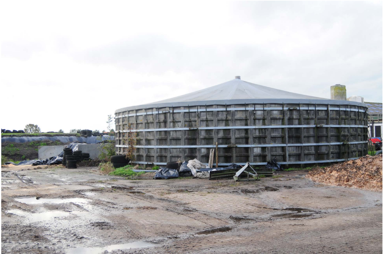
Afbeelding 12. De hogere mestsilo centraal op het achtererf, te verwijderen
