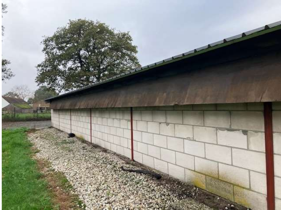
• Afbeelding 4: langsgevel te slopen stal
