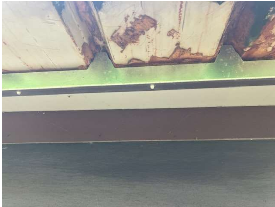
• Afbeelding 6: Onderzijde dak, sandwichpanelen, dicht gemaakt met metalen plaat
