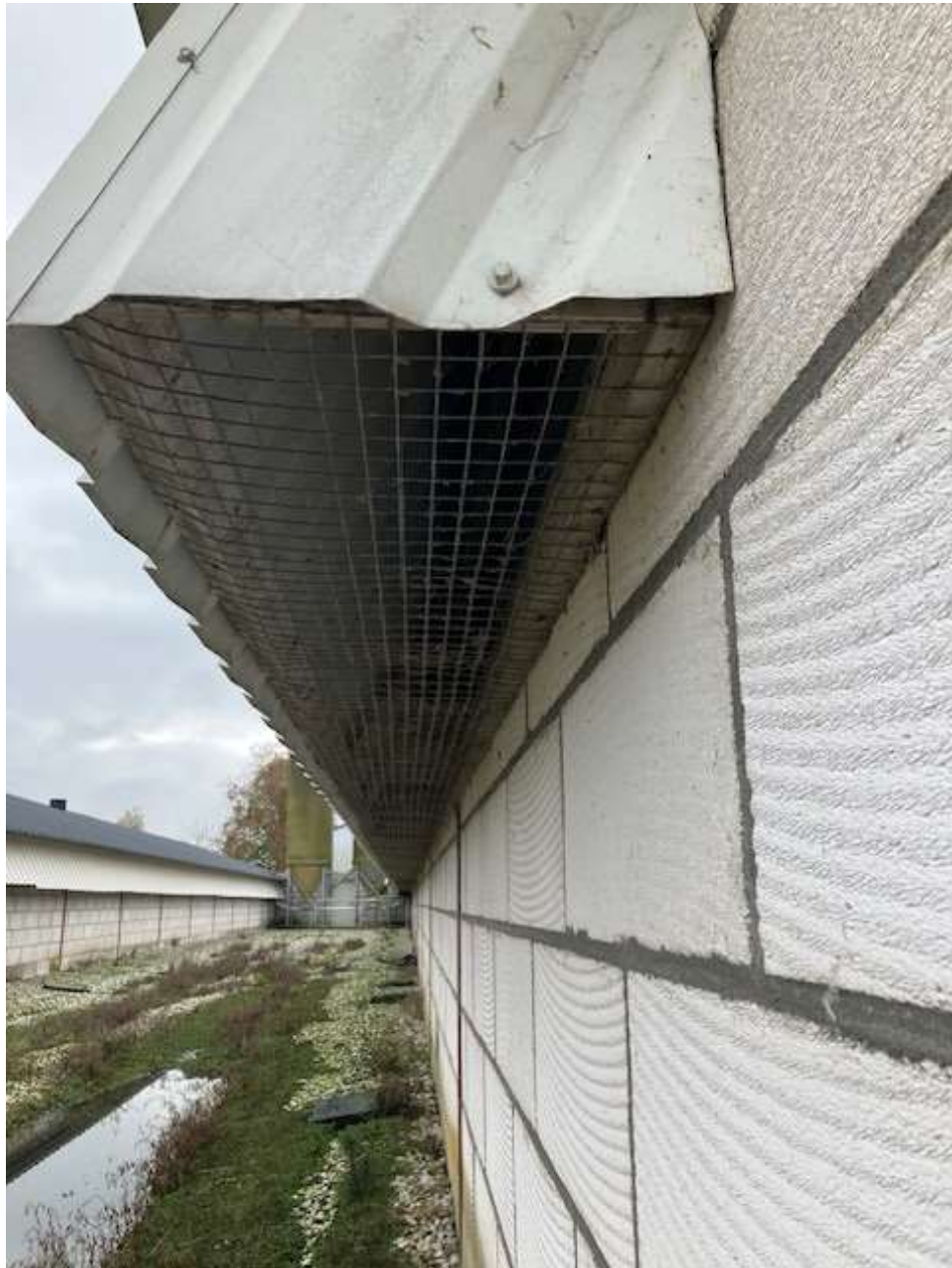
• Afbeelding 19: luchtinlaat bij de langsgevel
