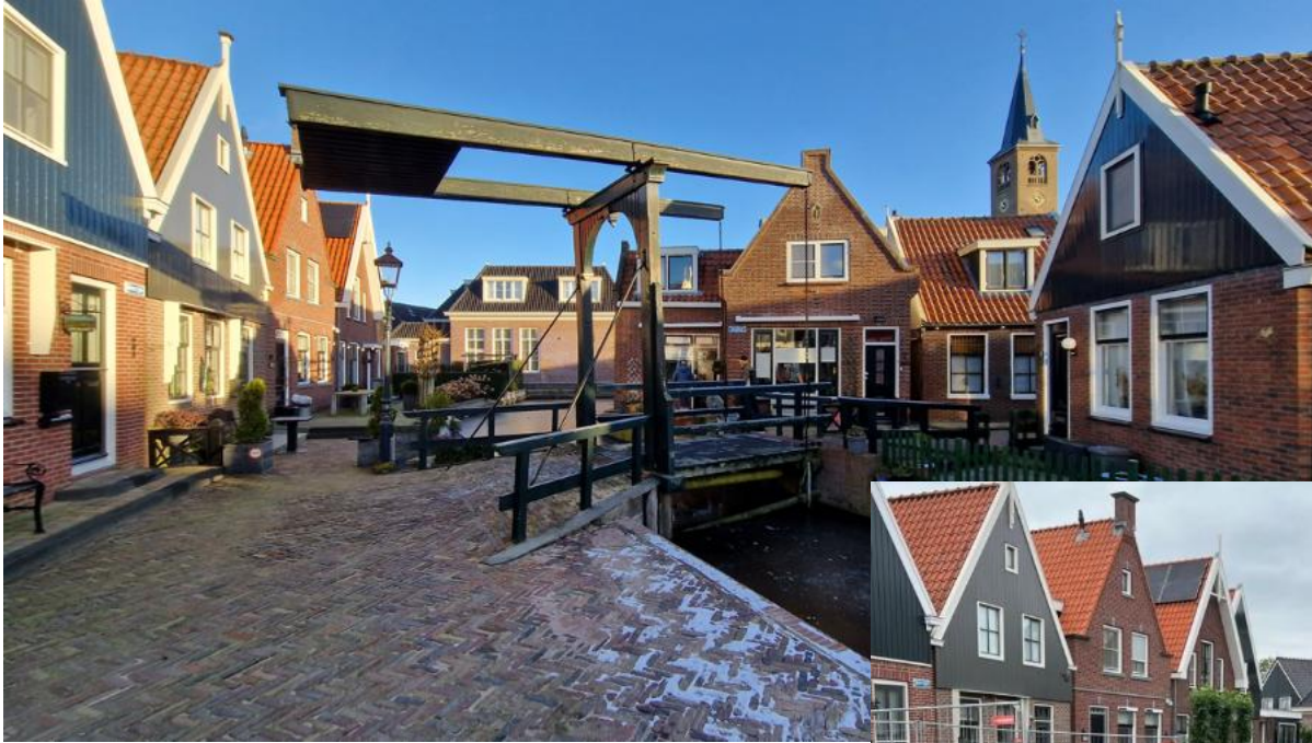
Foto – Brug V05 Blauwe brug, oude situatie
