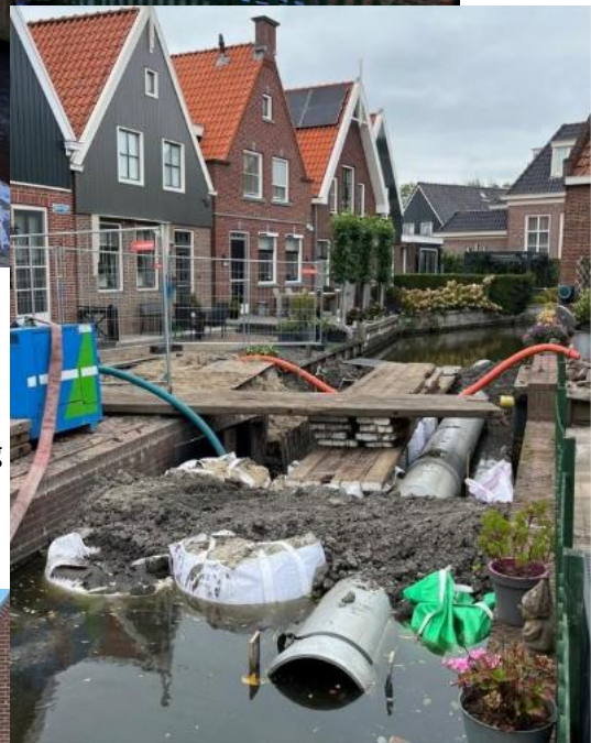
Foto - Brug V05 Blauwe brug, landhoofden in uitvoering
