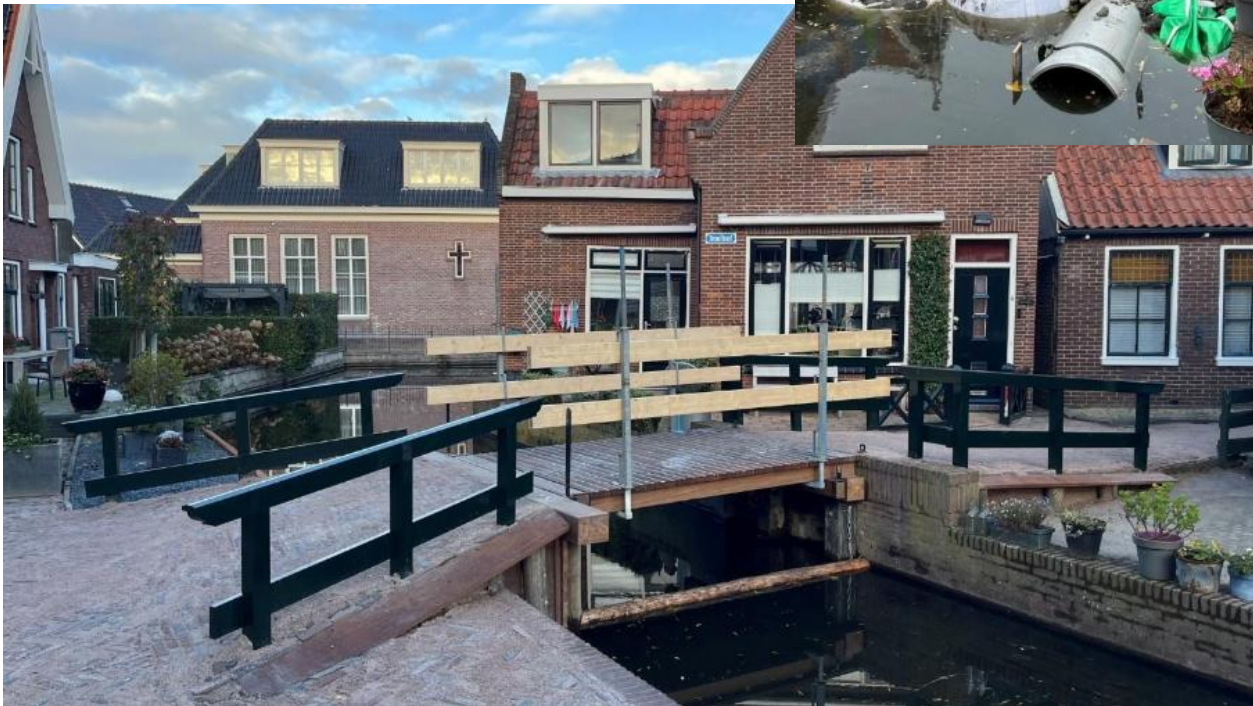
Foto – Brug V05 Blauwe brug, nieuwe situatie tijdelijk nog zonder bovenbouw
