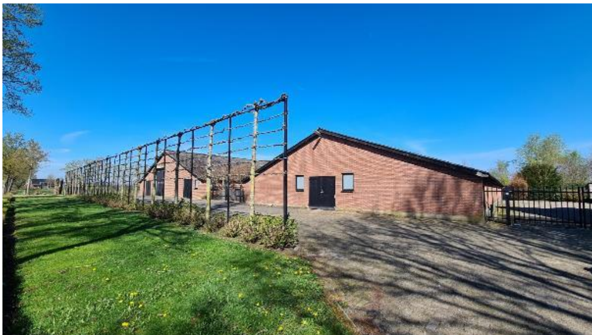
Figuur 2.2 Te slopen agrarische bebouwing in de huidige situatie (bron: BRO)
