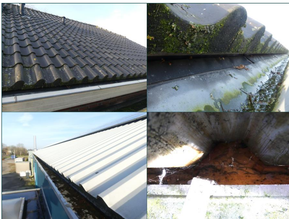
Figuur 3.2 Onder de dakpannen van de bedrijfswoning (boven) en onder de golfplaten van de bedrijfsruimte (onder) is een houten balk aanwezig.
