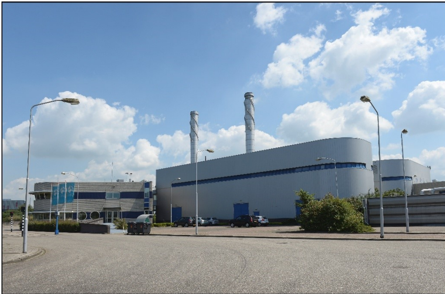
Slibdrooginstallatie in Beverwijk
