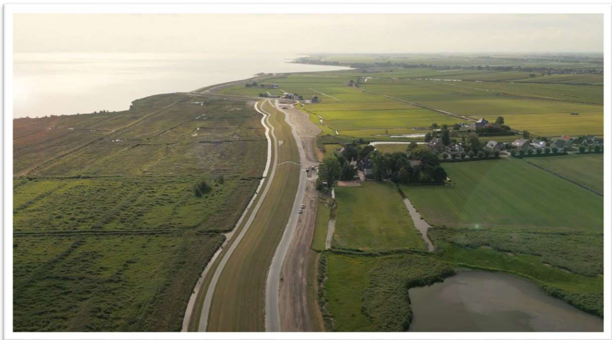
Afgerond deel van de Markermeerdijk nabij Etersheim kijkend richting Warder
