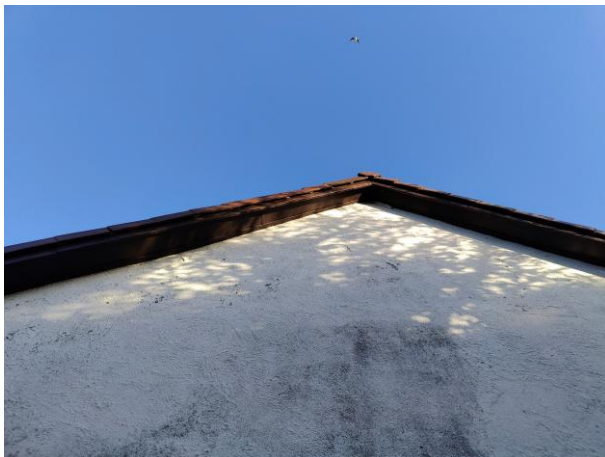
Figuur 6.1: Holle ruimte achter gevelbetimmering is toegankelijk via gevel(nok)pannen
