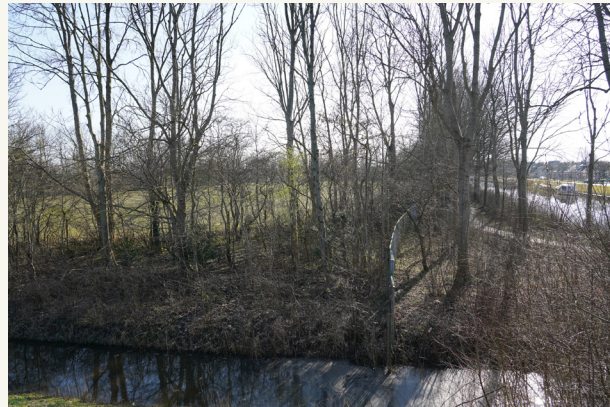
Onvoldoende onderhoud van de bomen.
