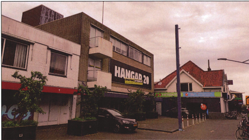
Afbeelding 1: huidige bebouwing Hangar 20 en de fietsenzaak
