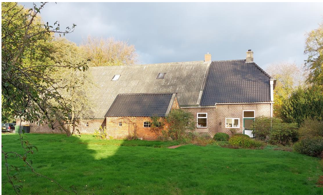
Figuur 1.2 De boerderij met rechts het woongedeelte en op de voorgrond het schuurtje.
