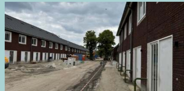
88 Nieuwbouw Heijmans Eindhoven Sociaal WOONST 1.0
